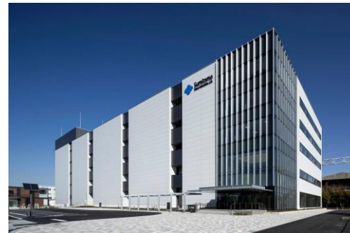
2025年4月開所の 技術研究・創発棟 「Cs'-Lab+」は ZEB Readyを取得
