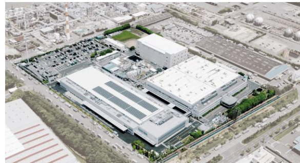
2023年度に温室効果ガス排出実質ゼロを達成した 堺製作所臨海工場
