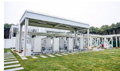
PECWで設置された純水素燃料電池（中国）
