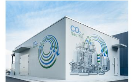
愛知県安城製作所に併設されたCO 2 循環プラント
