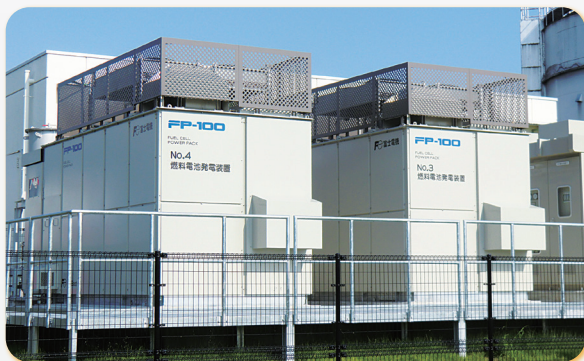
下水消化ガス利用 山形市内設置例
