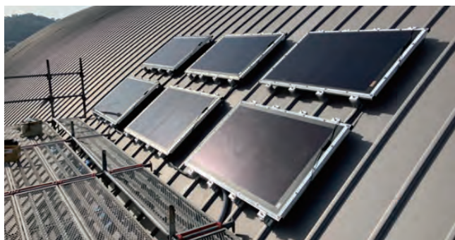
図7 ペロブスカイト太陽電池モジュール アーチ型屋根への施工例
