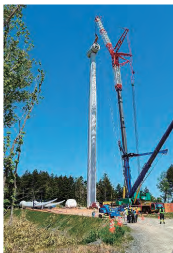
図 12 陸上風車のクローラークレーンによる建設状況 (北海道 豊富町、SGRE 製 4.3MW)
