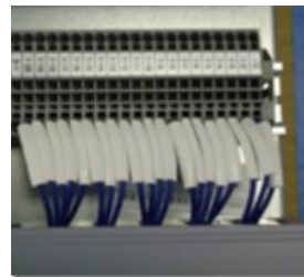
図12 フラットチューブとそれを使用した配線後の外観
