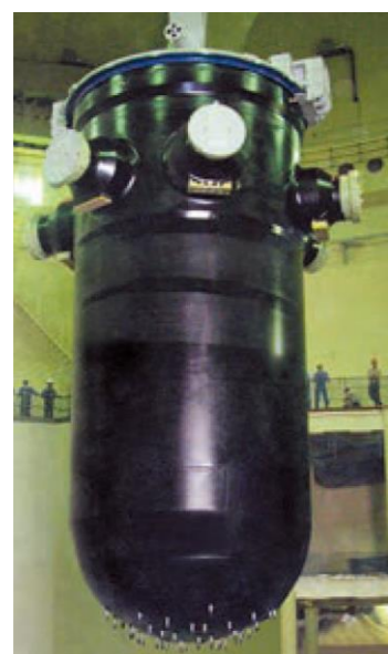
「原子炉容器の据付」
