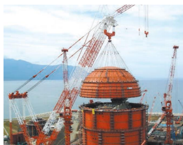
「原子力発電所の建設風景」
