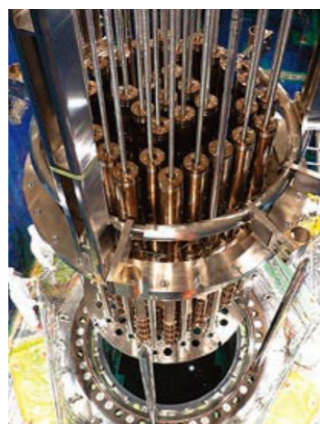
「炉内構造物の据付」
