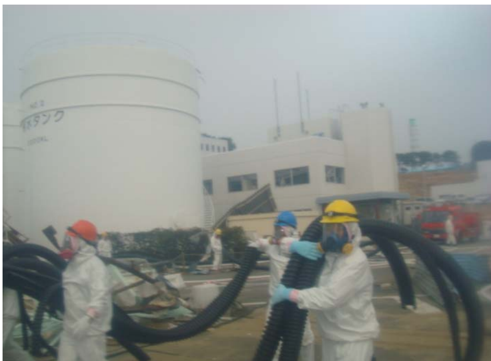
福島第一原子力発電所(1F)構内のケーブル敷設作業 (2012年3月18日)
