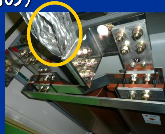
前頁にも共通するが、構造も重心も異なる配電盤(筐体)と変圧器は震災時、異なった振動をする。
