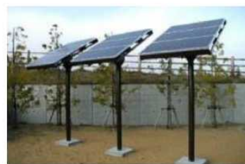
既存のシリコン太陽電池パネル上への設置
