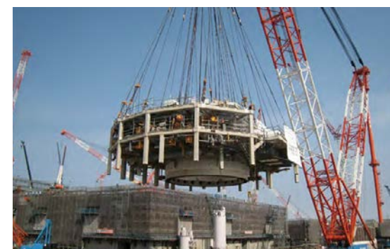
ドライウェル機構(610t)の搬入
