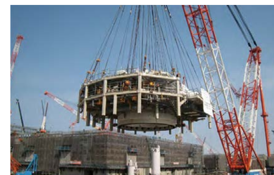
ドライウェル機構(610t)の搬入
