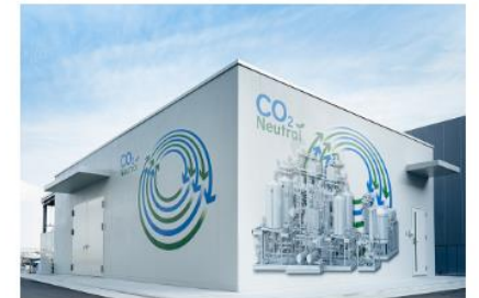
愛知県安城製作所に併設されたCO 2 循環プラント
