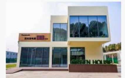
燃料電池システムを制御するグリーンハウス
